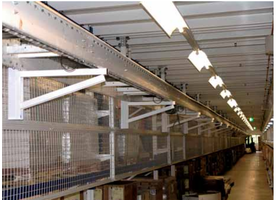
Transporttrasse mittels Powerclick System 63 und vormontierten Konsolen Transportation route with Powerclick System 63 and pre-assembled cantilever arms
