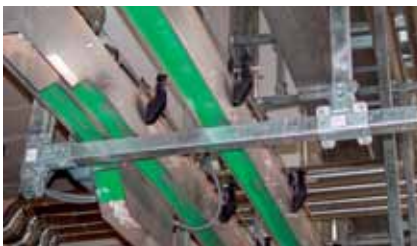
Montage der Förderbänder erfolgte mit dem HALFEN Powerclick System 63 Assembly of conveyor belts was carried out with the HALFEN Powerclick system 63
