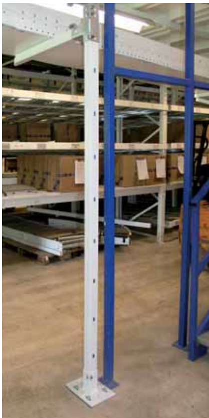
Aufgeständerte Kragarm-Unterkonstruktion für eine erweiterte Förderanlage Supported boom sub-structure for an extended conveyor system
