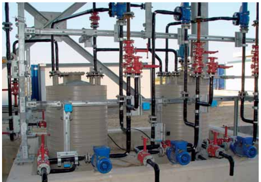
Anbindung in alle Richtungen durch multifunktionale Verbindungsteile Connection in all directions by multi-functional connecting components
