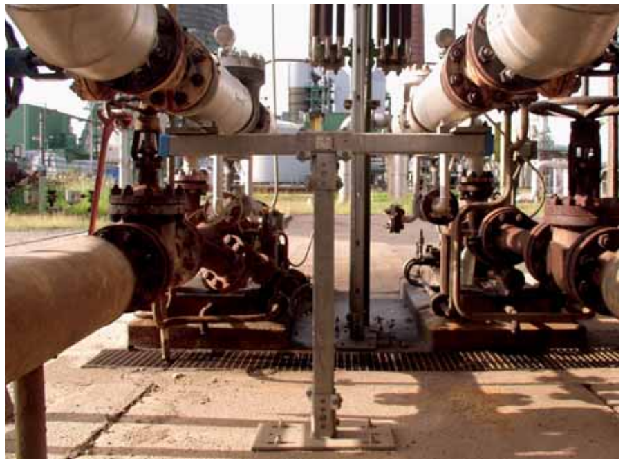
Einfache Montage einer T-Konstruktion mittels HALFEN Powerclick Easy assembly of a T-construction with HALFEN Powerclick
