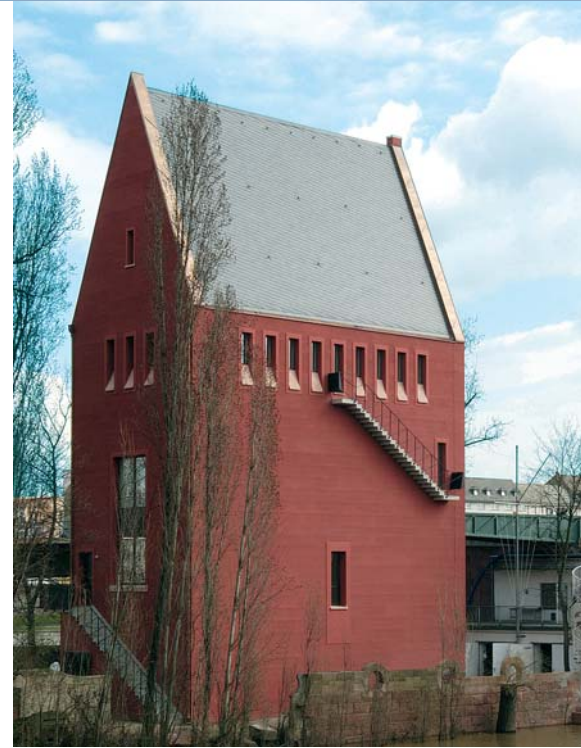
Renovation „Kunsthalle Portikus“, Frankfurt a.M. Renovation „Kunsthalle Portikus“, Frankfurt a.M.
