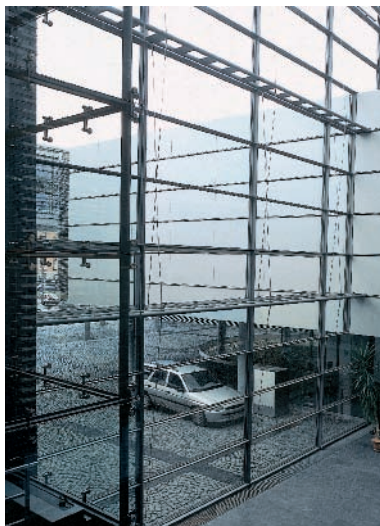
Landgerichts-Gebäude, Meiningen/D Regional court building, Meiningen/D
