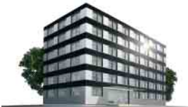
Bestandsgebäude nach der Modernisierung Existing building after modernisation
