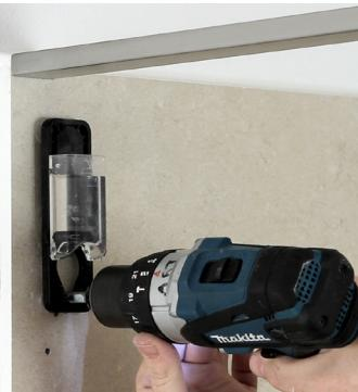
Brusedøren fjernes, og de opmærkede punkter bores ud med et 6 mm flisebor. **BEMÆRK:** Fliser er meget forskellige. Nogle fliser er hårdtbændte og kræver derfor særligt bor og boregrej. Væggen bag fliserne er ideelt set enten lavet af beton eller mursten, og her kan de medfølgende 6 mm rawplugs anvendes uden videre.
