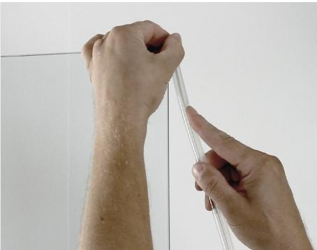
Kun suihkuovi on paikallaan, sitä voidaan tarvittaessa säätää hiukan. Löystytä ruuveja hiukan, säädä ovea haluttuun asentoon ja ruuvaa sitten ruuvit tiukasti kiinni. Lopuksi, kiinnitä kumitiiviste paikoilleen.
