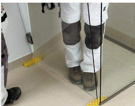
Sæt brusedøren ind på opklodsningen, så de to hængsler støder tæt ind til fliserne. Herefter skal du tjekke, om brusedøren er placeret rigtigt med den rette afstand til alle fire sider. Op, -ned og sidevært. Når de to stålhængsler er skruet fast på væggen, kan brusedøren justeres i alle fire retninger med +/- 2-3 mm.
