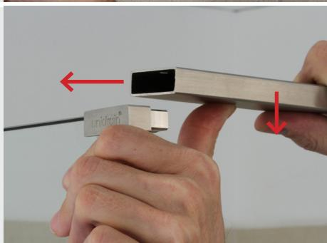
Odciągnąć ścianę prysznicową, aby umożliwić wsunięcie szyny w odpowiednie miejsce.
