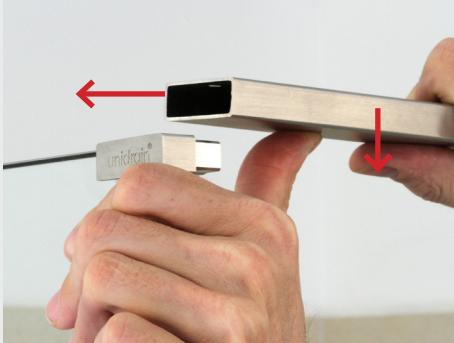
Placer den afskårede topstang i glasbeslaget, ved at trække brusevæggen til siden, så stangen kan komme forbi og i position.
