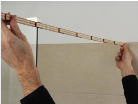
Mål afstanden fra glasbeslaget til flisevæggen på modsatte side.
