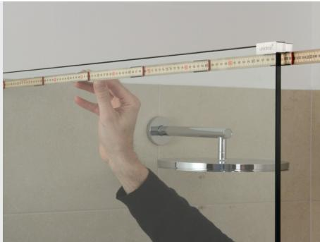
Mål dybden af brusenichen fra fliserne på væggen til unidrain® glasbeslaget.
