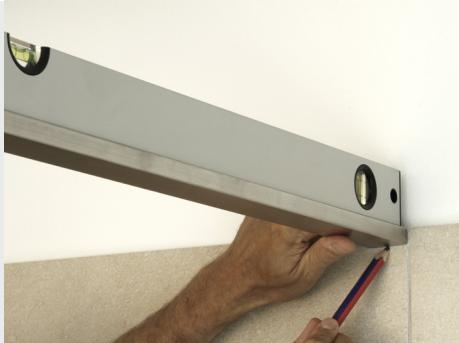
Hold topstangen vandret ved hjælp af et vaterpas og afsæt mærker på fliserne rundt om topstangen.
