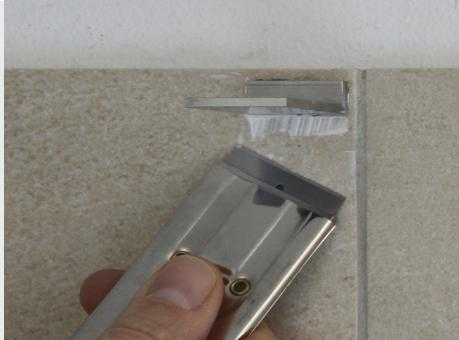
Po odklejeniu bloku piankowego widoczne mogą być wycieki nadmiaru kleju, które należy usunąć skrobakiem lub nożem z łamany ostrzem.
