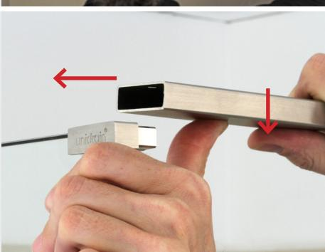
Umieścić przyciętą górną szynę w uchwycie na szybę poprzez odciagnięcie ściany prysznicowej w bok, tak aby umożliwić wsunięcie szyny w odpowiednie położenie.
