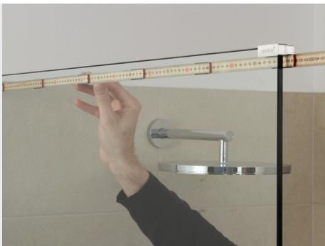
Zmierzyć głębokość kabiny prysznicowej od glazury na ścianie do uchwytu na szybę unidrain®.
