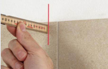
Pomiar należy wykonać dokładnie w miejscu, gdzie przymocowana zostanie górna szyna.
