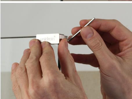
UWAGA: Dokręcić śruby do wyczucia oporu, a potem jeszcze o ćwierć obrotu.
