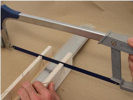
Skær topstangen til med en nedstryger og gerne i en "skærekasse" (OBS: Pas på ikke at ridse stålet).
