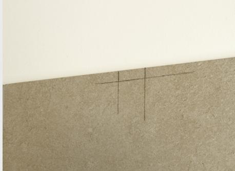
Oznaczania do ustawienia bloku piankowego.
