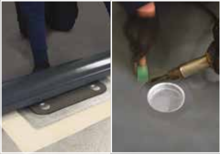
4- Thermal weld
