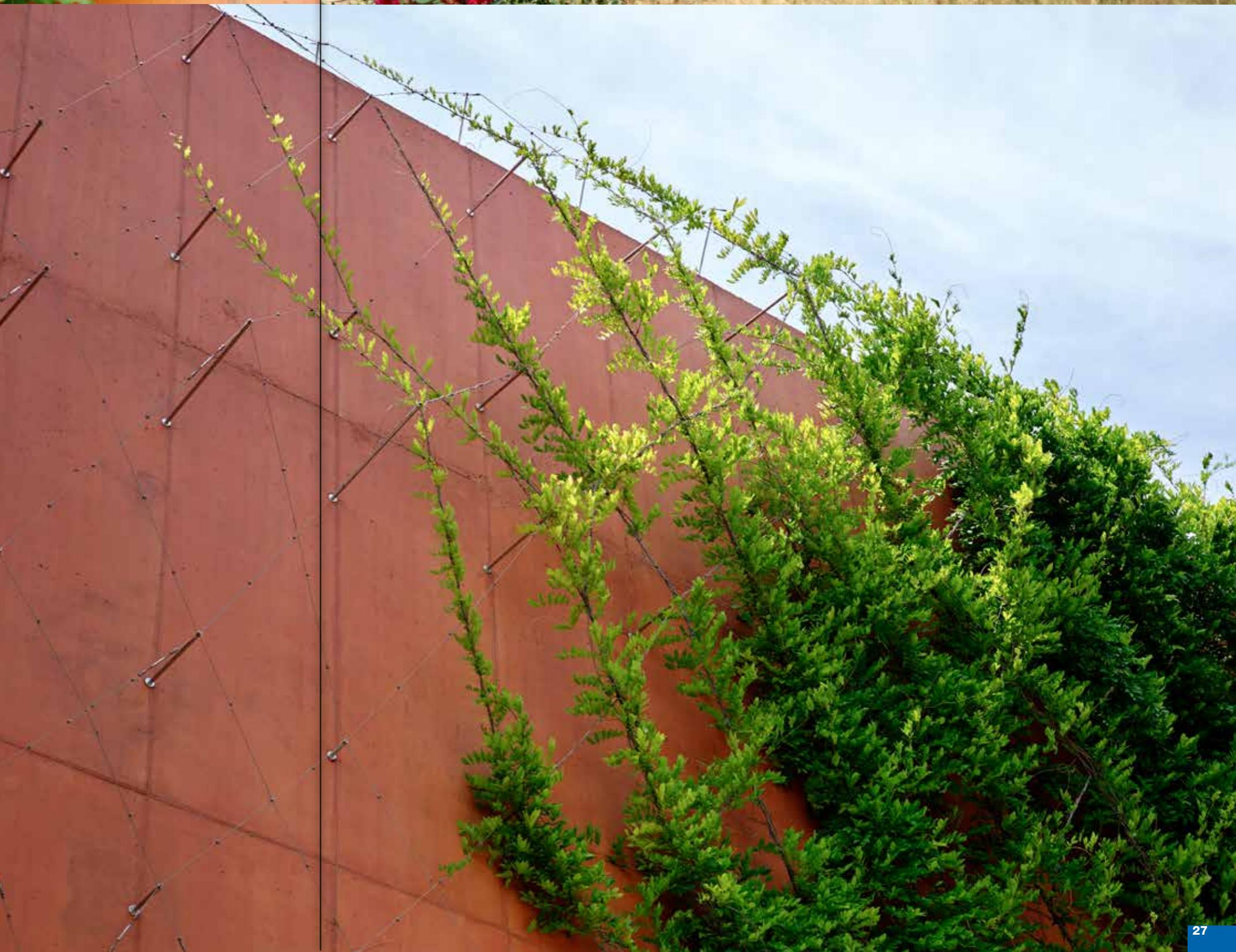
■ Mit unserem Webnet entstand eine dreidimensionale Rankhilfe für eine Innenbegrünung im Eingangsbereich, aufgehängt an einer Seil-Primärstruktur aus Edelstahl.
