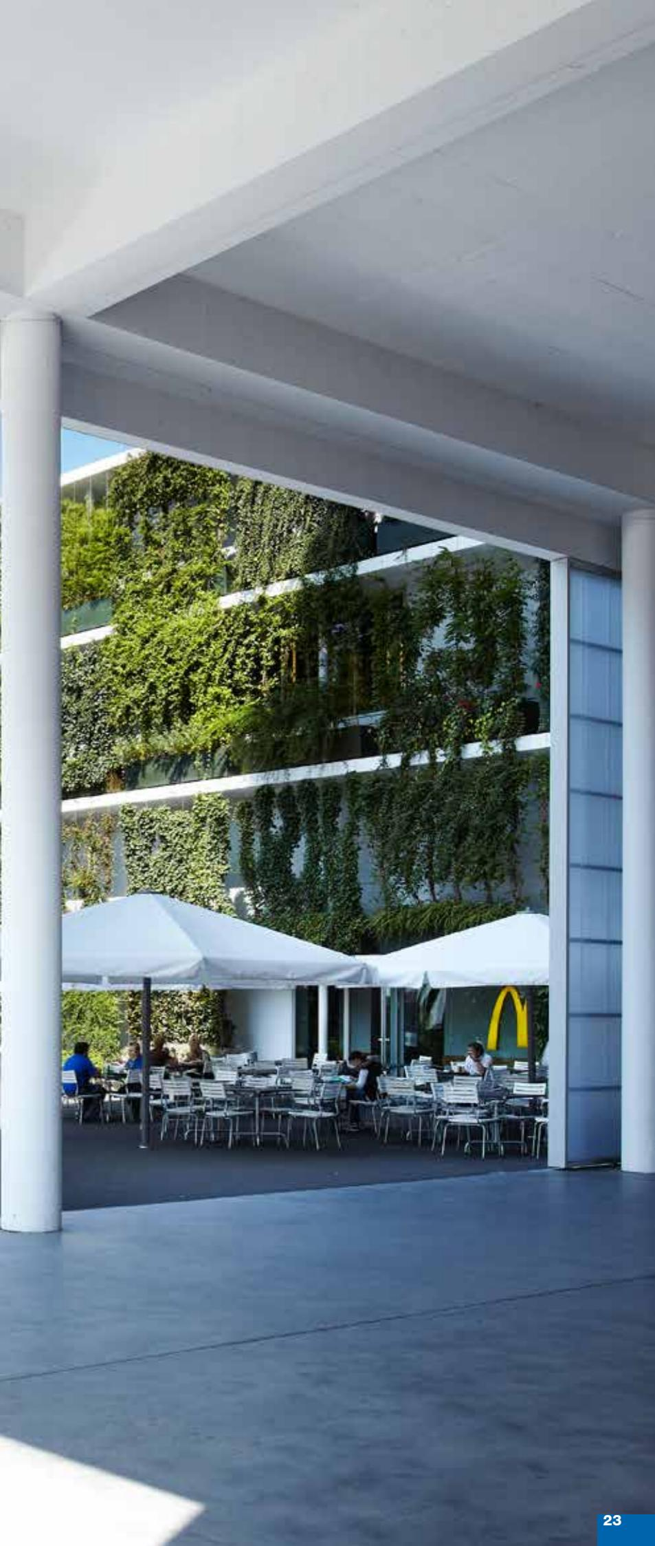
■ Die 600-m<sup>2</sup>-Rankhilfe mit Jakob<sup>®</sup>-Edelstahlseilen zeigt die Möglichkeiten der bodengebundenen Begrünung. Die stark schlingenden Wisterien erfordern gezielte Massnahmen zum Schutz der Kletterhilfen vor Überlastung.
