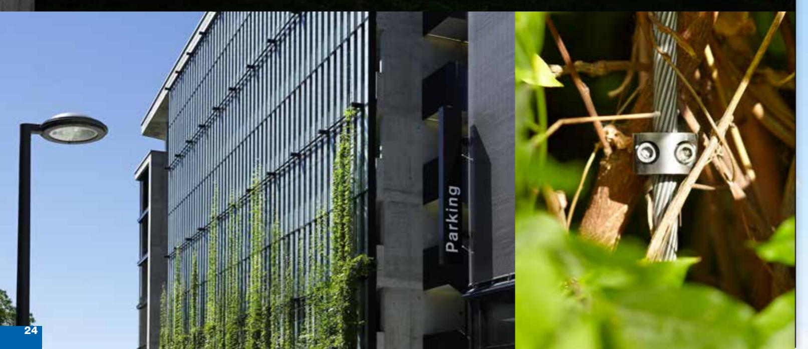
■ Die Begrünung am Fernwärmekraftwerk, mit einer rautenförmigen Kletterhilfe aus Edelstahlseilen, bildet einen wesentlichen Bestandteil des architektonischen Konzeptes.
